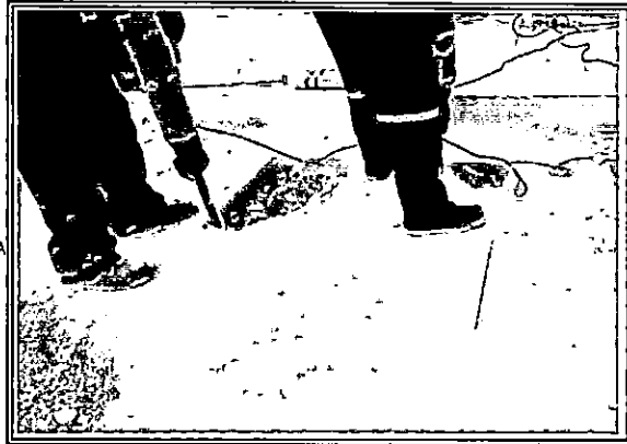
USO DE MARTILLO DEMOEDOR DE PAVIMENTO PARA LA EXCAVACION DE HOYO PARA INSTALACION DE PUESTA A TIERRA
