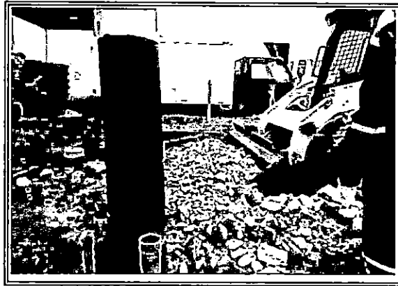
RETIRO DEL DESMONTE PRODUCTO DE EXCAVACION DE ZANJA PARA LINEA SUBTERRANEA (0.60X1.05) TERRENO MUY ROCOSO.
